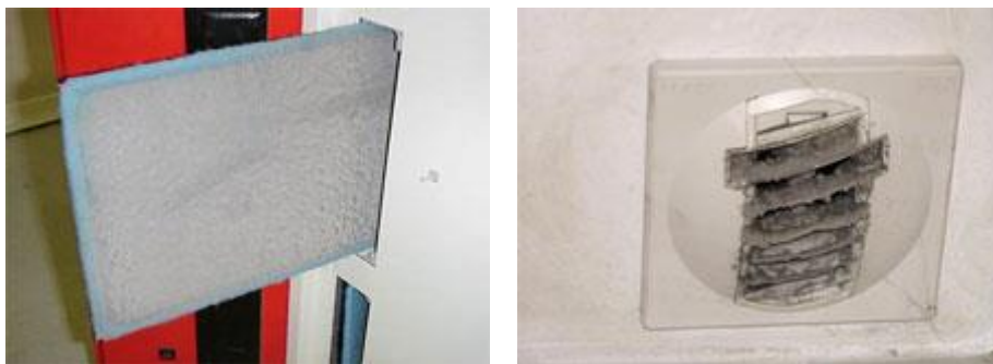
Afb. 1 Voorbeelden van componenten die een regelmatig onderhoud vereisen: de filters en de ventielen.
