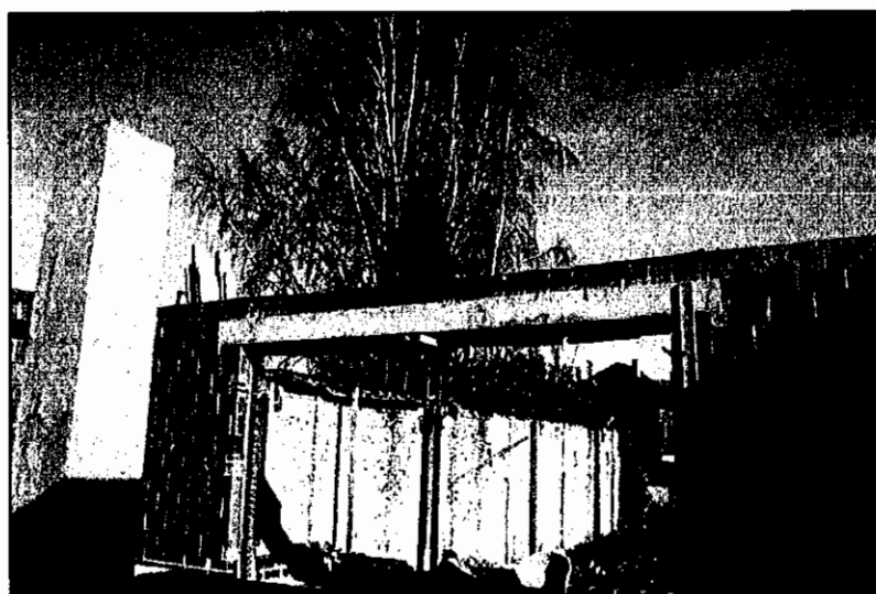
betonbalk achtergevel, linkse handelspand.
