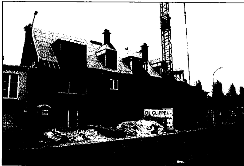
overzicht straatgevel. – valgevaar !
