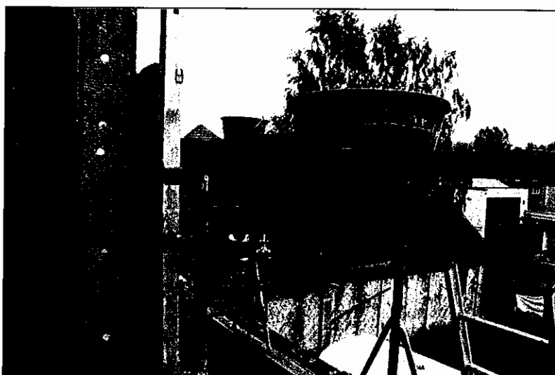
ontbrekende valbeveiliging te smalle werkvloer.
