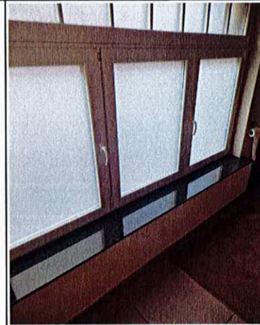
Foto 12: 233: ontbrekende of onvoldoende hoge/stevige borstwering bij lage ramen (vanaf eerste verdieping)
