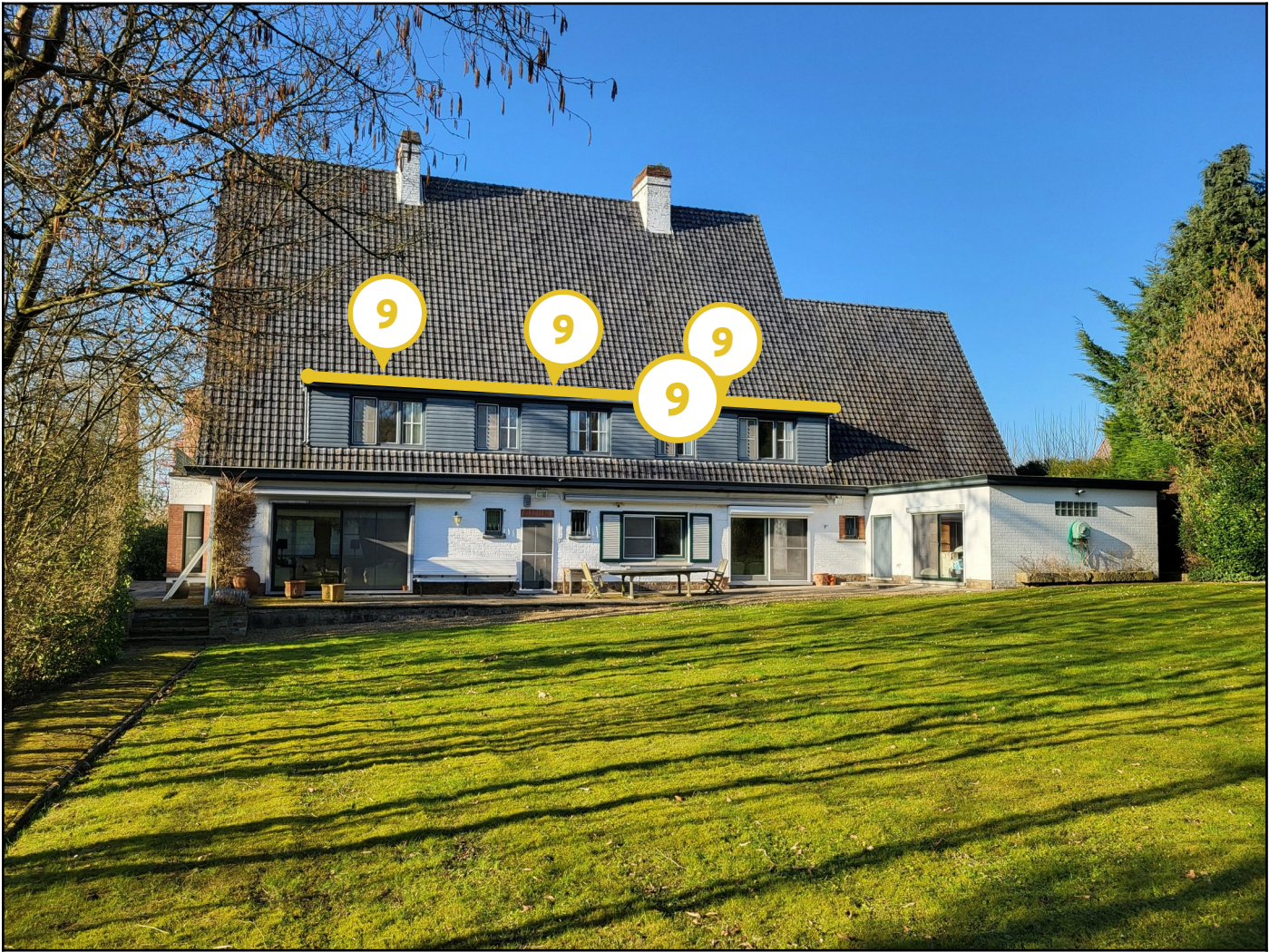
Legende van plan 1.14: Roofing boven kapellen achtergevel
