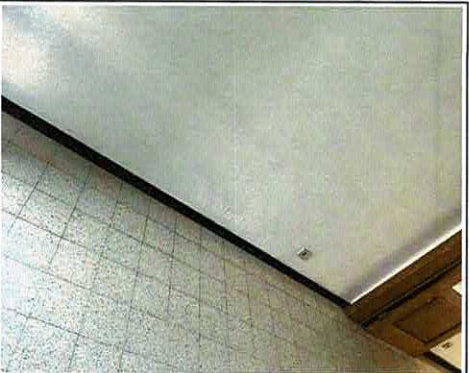
Foto 2: 111: opstijgend vocht / doorslaand vocht Woonkamer voorraan
