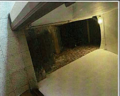
Foto 3: 111: opstijgend vocht / doorslaand vocht Woonkamer voorraan
