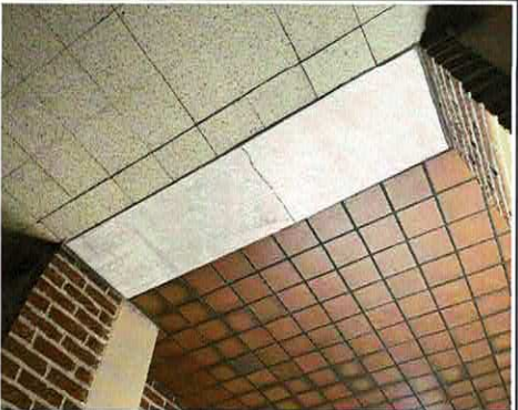
Foto 2: 111: opstijgend vocht / doorslaand vocht Woonkamer voorraan
